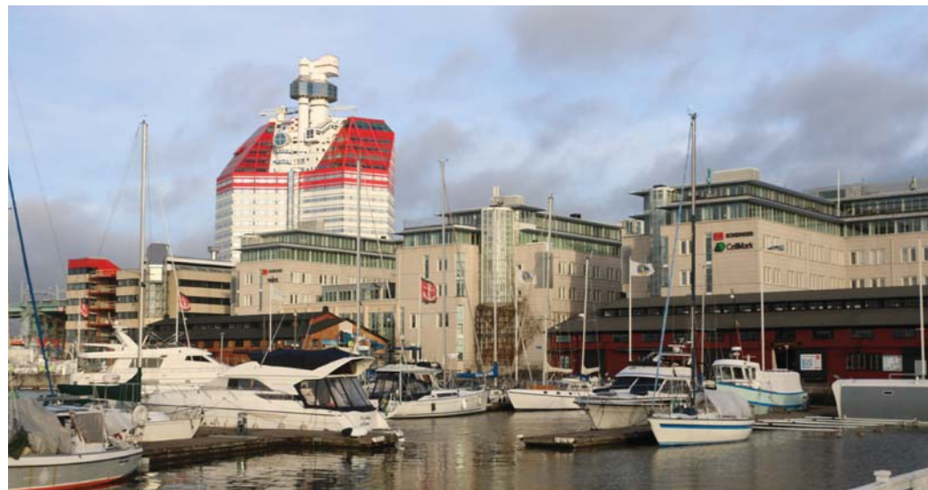
LILLA BOMMEN OMGIVET AV LÄGRE KONTORSBYGGNADER OCH DE TVÅ BEVARADE HAMNSKJULEN UTMED KAJKANTEN.
