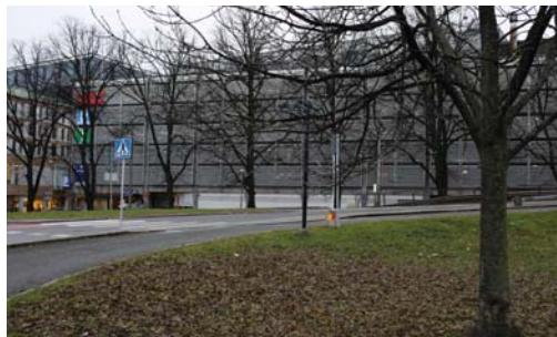
PARKERINGSHUSETS FASAD MOT ÖSTER
